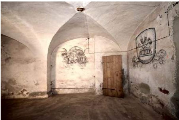
Kreuzgewölbe, Durchgang zum Nebenraum
