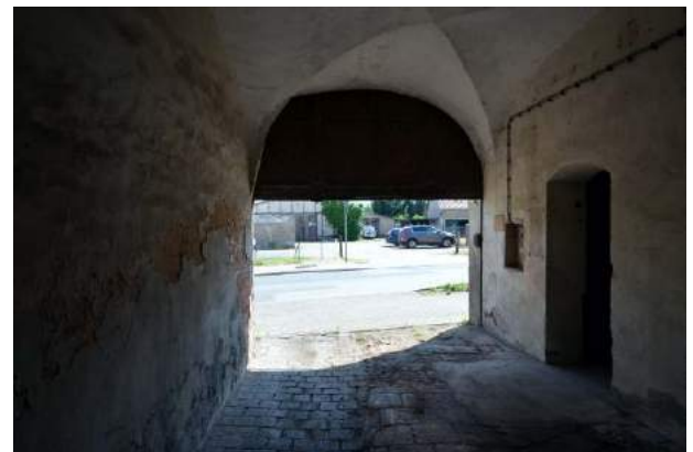
Torweg, rechts - Eingang zum ehemaligen Schankraum
