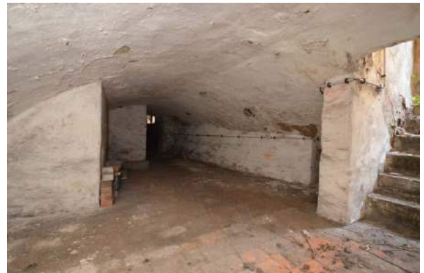
Sudhaus, Keller mit Tonnengewölbe
