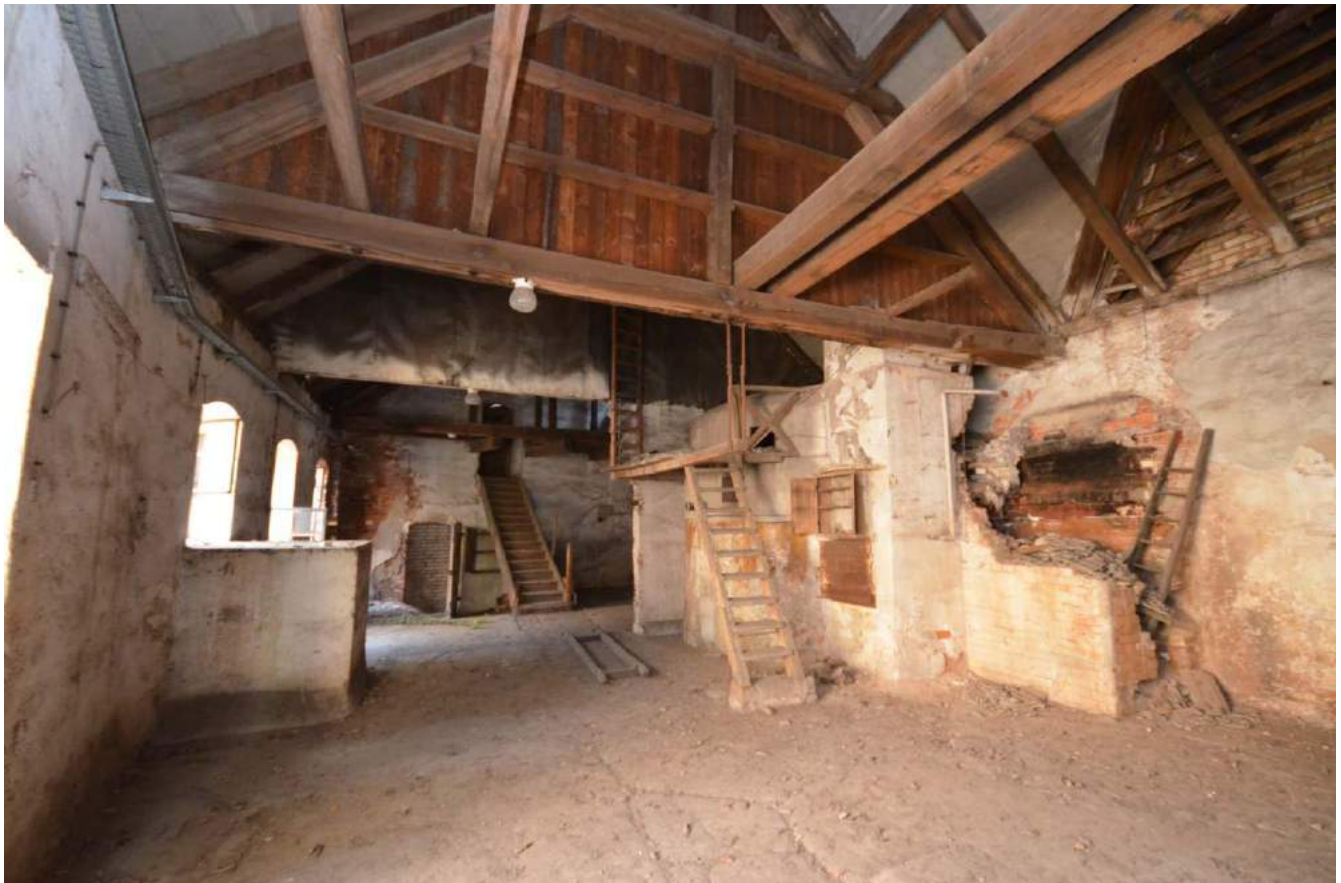
Sudhaus mit Treppe zu den Obergeschossen im Malzhaus
